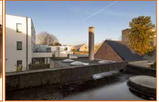
De lichtkoepels in het dak
