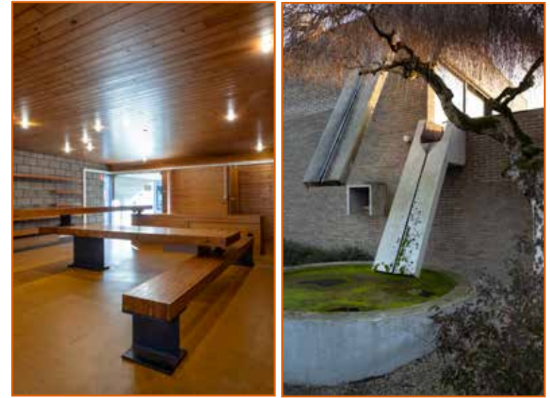
Woning De Vos-Smesman, Stationsstraat 28, detail van de afwatering van het dak
